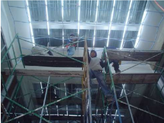
SUMINISTRO, COLOCACIÓN Y CONEXIÓN DE LUMINARIAS ESPECIALES
