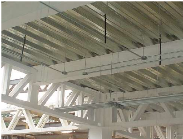
CANALIZACIÓN PARA ALUMBRADO
