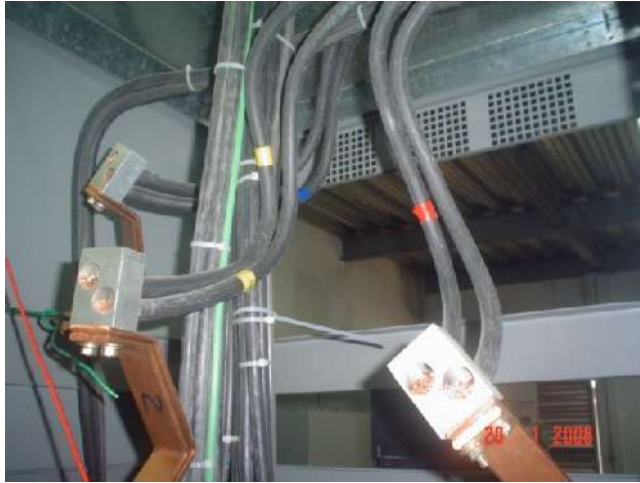
ADAPTACIÓN DE INTERRUPTOR DERIVADO SIN CORTE DE ENERGÍA ELÉCTRICA
