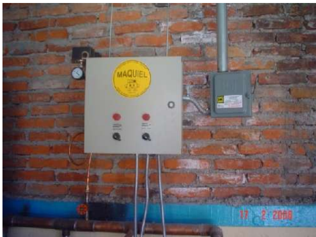
CONEXIÓN DE EQUIPOS HIDRONEUMÁTICOS
