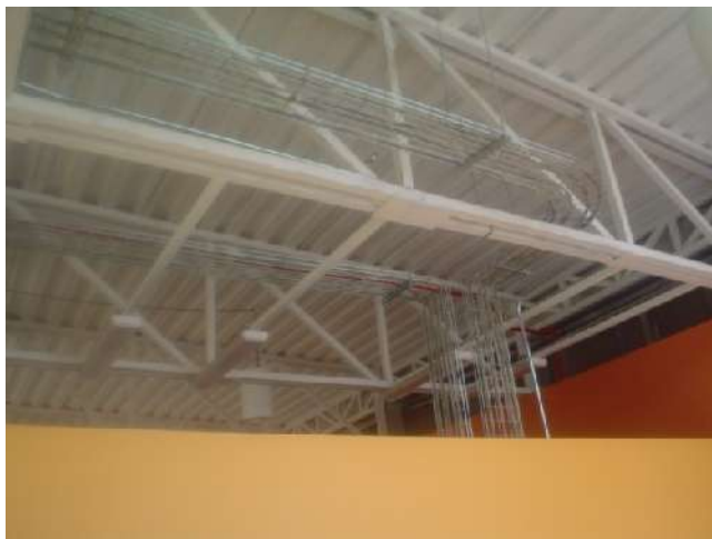
SUMINISTRO E INSTALACIÓN DE SOPORTE PARA CABLES DE MALLA ELECTROSOLDADA (CHAROFIL)
