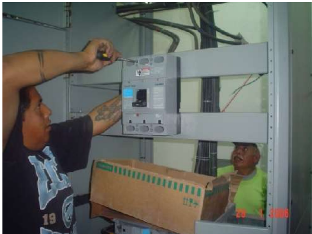
ADAPTACIÓN DE INTERRUPTOR DERIVADO SIN CORTE DE ENERGÍA ELÉCTRICA
