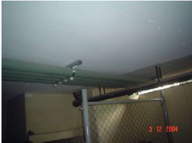
CANALIZACIÓN PARA EL CAMBIO DE ACOMETIDA ELÉCTRICA
