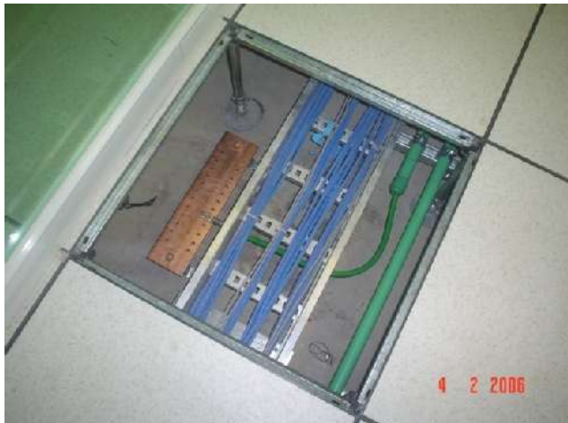
SISTEMA DE TIERRAS FÍSICAS PARA EQUIPOS DE TELECOMUNICACIONES
