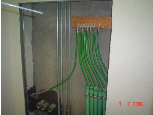
SISTEMA DE TIERRAS FISICAS PARA EQUIPOS DE TELECOMUNICACIONES
