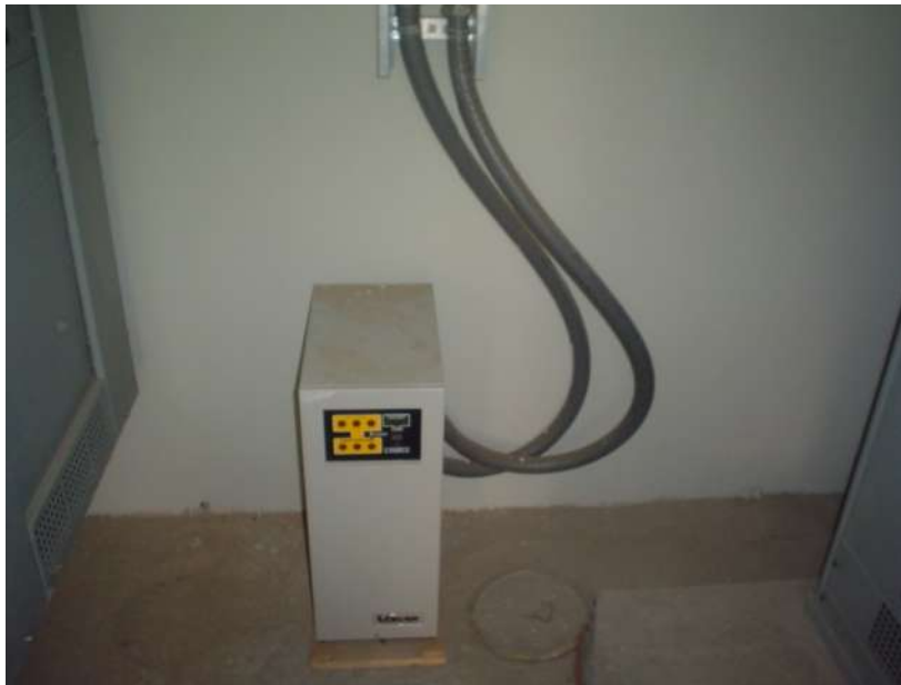
SUMINISTRO Y CONEXIÓN DE EQUIPOS REGULADORES Y DE RESPALDO DE ENERGÍA ELÉCTRICA
